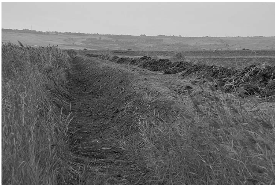
Fig. 2 — Il Pantano di Gelsari dopo l'attivazione degli impianti idrovori. La fotografia, scattata dallo stesso punto della fotografia di Fig. 1, evidenzia l'asportazione della vegetazione naturale, il ripristino dei canali in terra, l'aratura del fondo del pantano.
